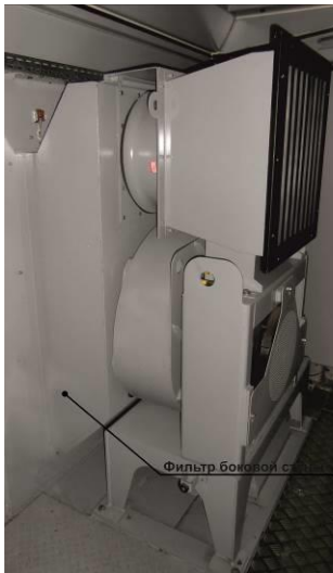
Рисунок 8.2 – Место установки фильтра очистки воздуха
