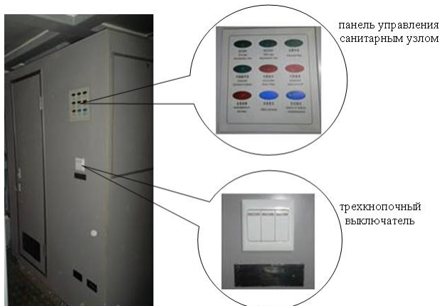
Рисунок 17.3 – Расположение органов управления санузла
