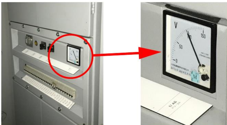
Рисунок 18.8 – Расположение вольтметра цепей управления «УАБ PV-BA» в блоке МСУД
