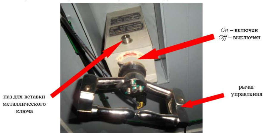
Рисунок 19.7 – Высоковольтный разъединитель QS-HV
