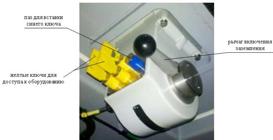
Рисунок 5.12 – Ключевой коммутатор крышевого заземлителя
