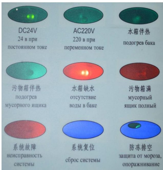
Рисунок 18.14 – Панель управления санитарным узлом
